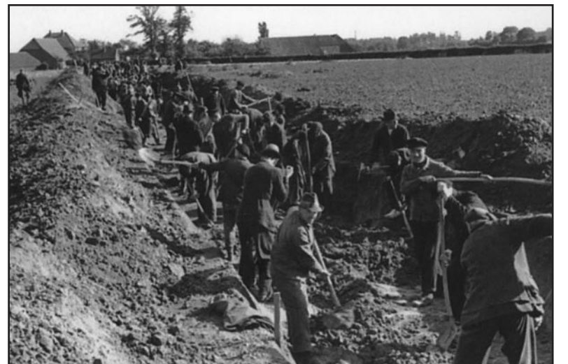
Graafwerk voor de loopgraven tijdens de Tweede Wereldoorlog.
